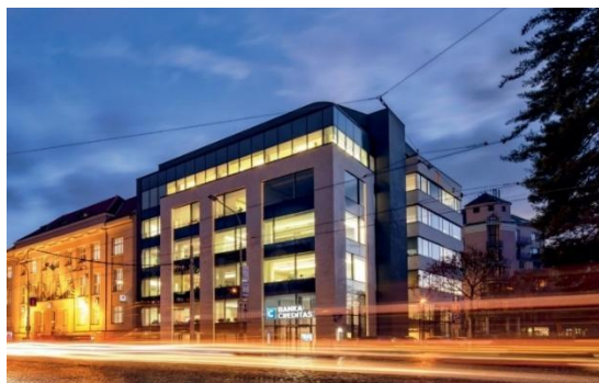
Administrativní budova v Olomouci
