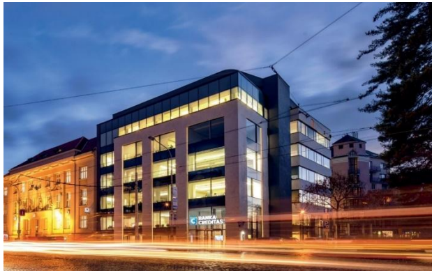
Administrativní budova v Olomouci
